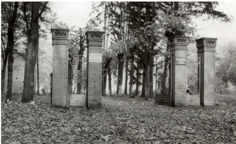
The old entry gate. Photographer unknown. Courtesy of Archiwum Wojewódzkiego Konserwatora Zabytków w Szczecinie [Archive of the Regional Monument Conservator in Szczecin].
